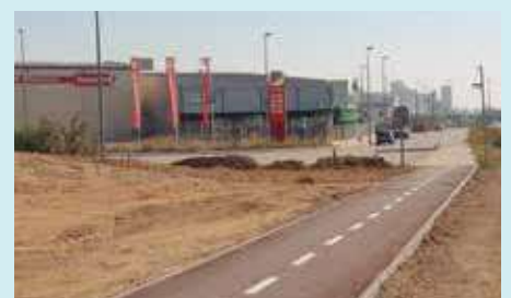
Carril bici a su llegada al polígono industrial El Sosal
